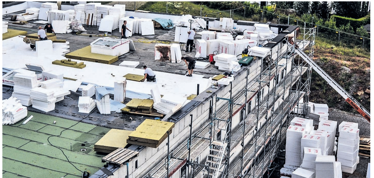
Die Arbeiten am Klinikneubau gehen voran: Dachdecker isolieren derzeit das Flachdach des Anbaus.
