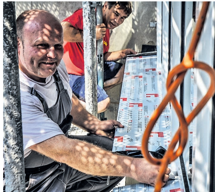
Bis zu 20 Handwerksbetriebe arbeiten derzeit in und an dem Rohbau. Mike Kraus (links) installiert Fensterelemente.
